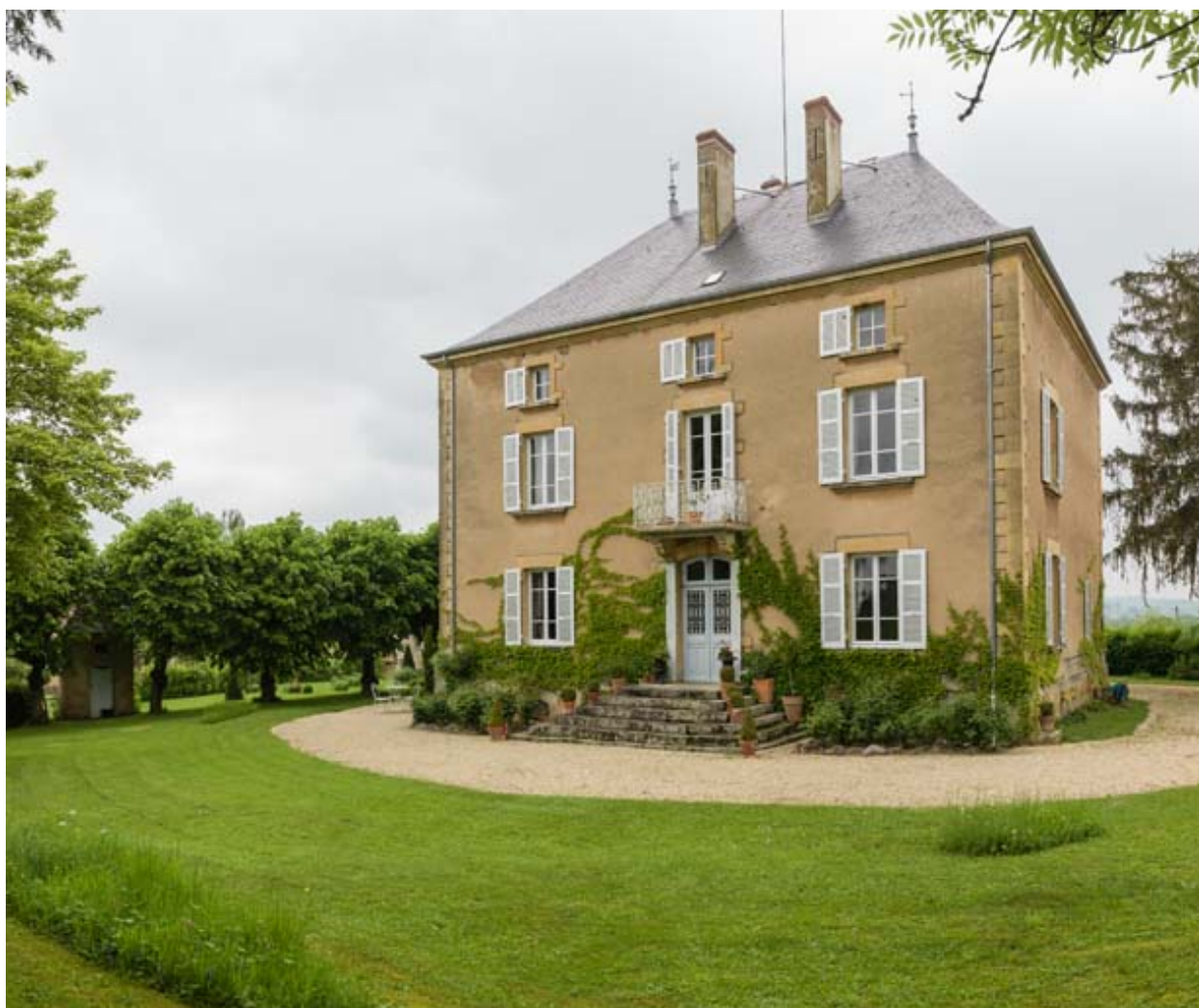
Façade postérieure, vue de trois quarts droite.
