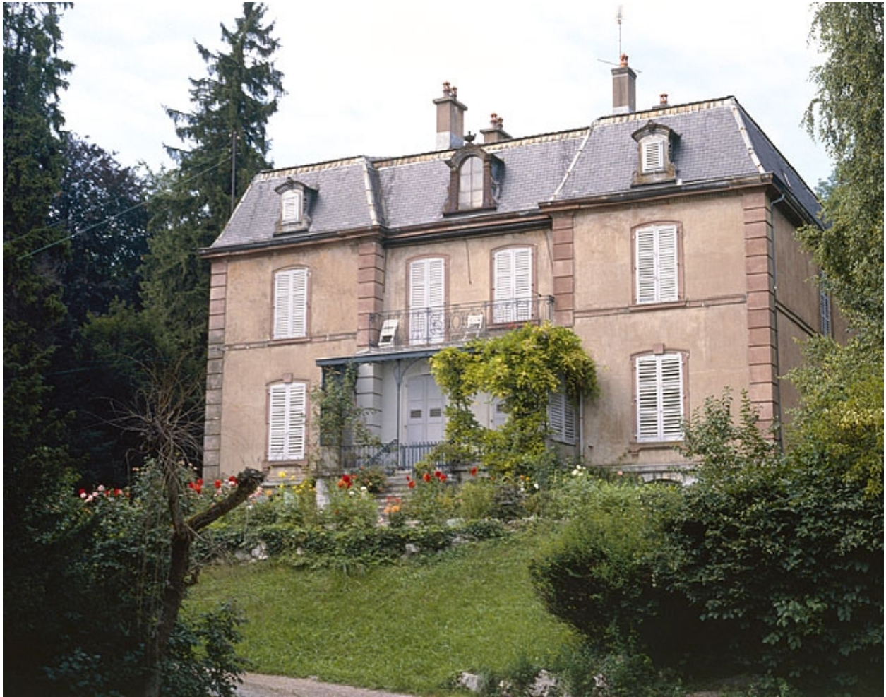
Façade sud du corps de bâtiment principal.
