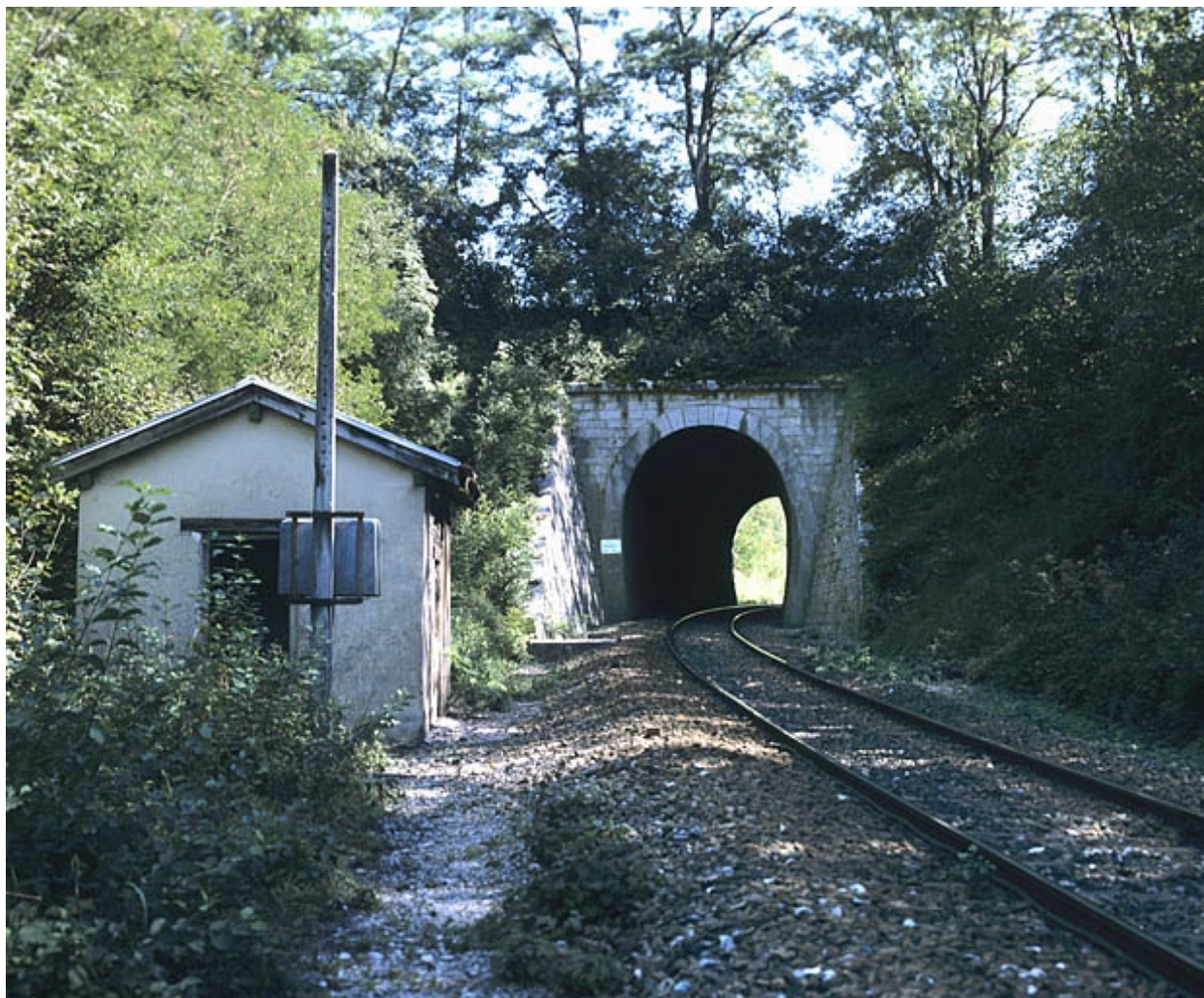
Tunnel d'Arbent 2 : tête côté Andelot-en-Montagne (ouest).
