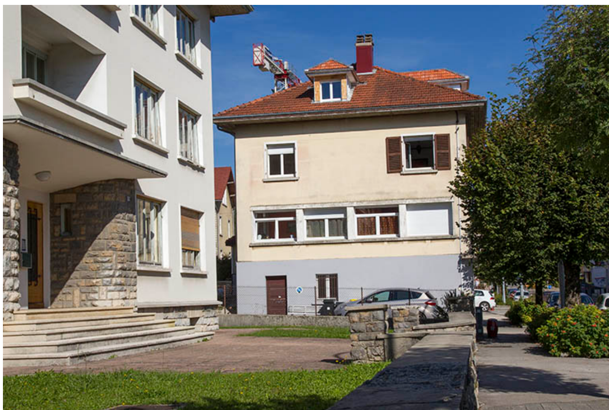
Façade latérale gauche.
