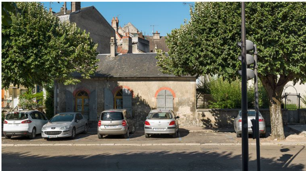
L'ancienne maison éclusière, de face.
