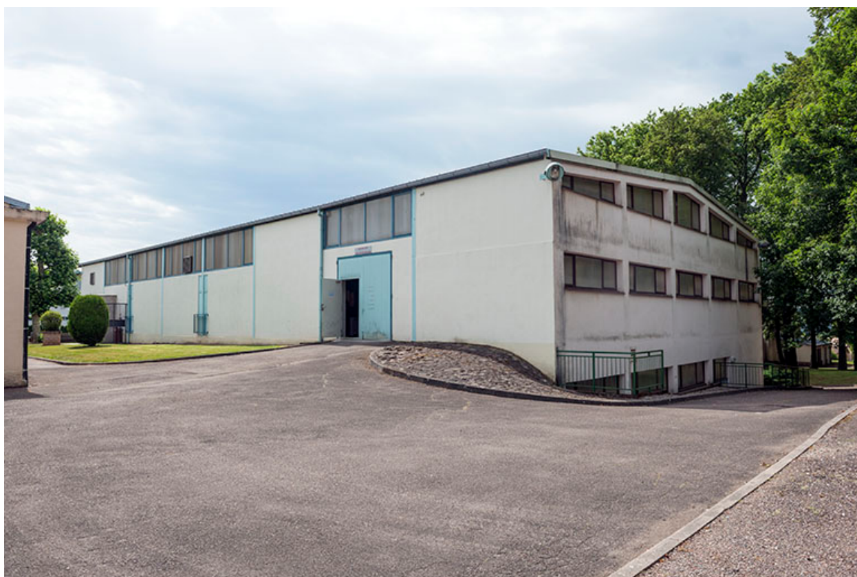
Atelier de gros-oeuvre : façade antérieure.
