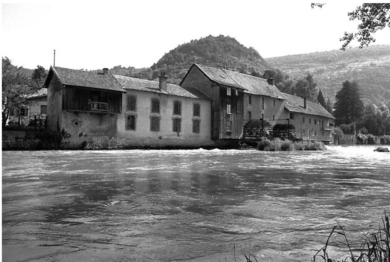
Moulin situé route de Pontarlier.
