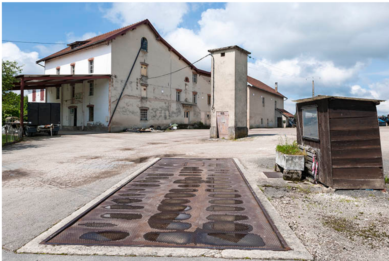
Vue d'ensemble depuis le pont bascule.
