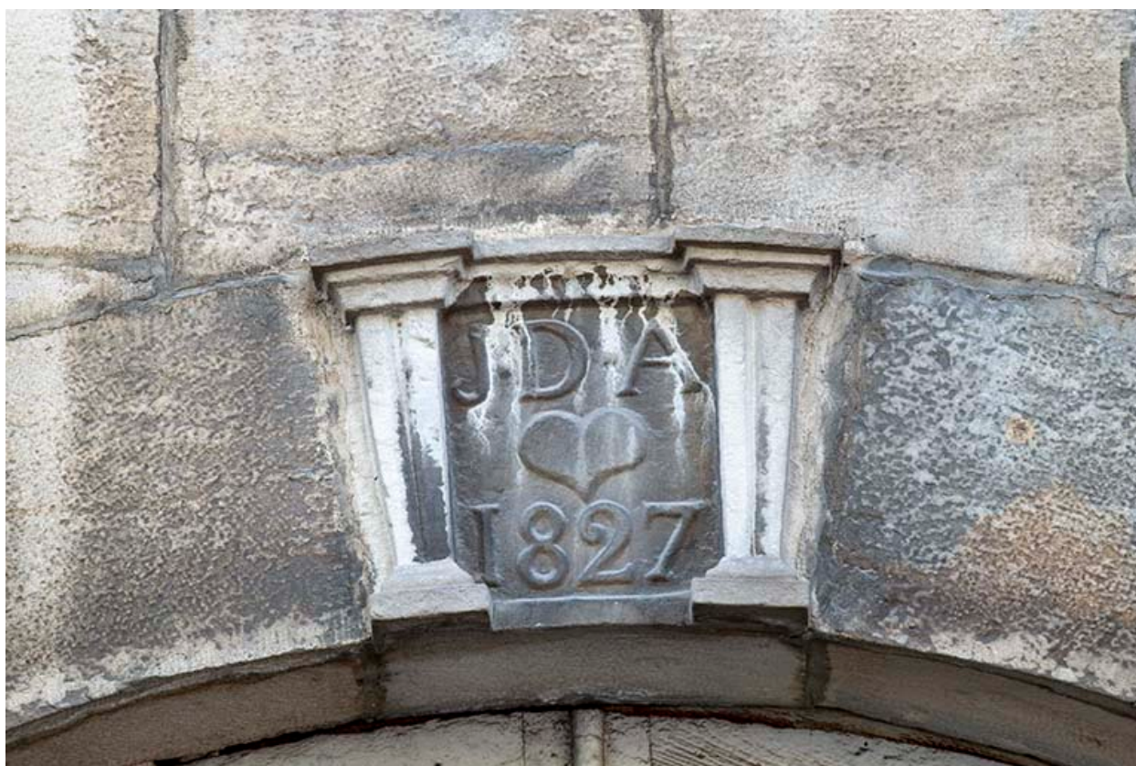
Façade antérieure. Clef de l'arcade centrale.
