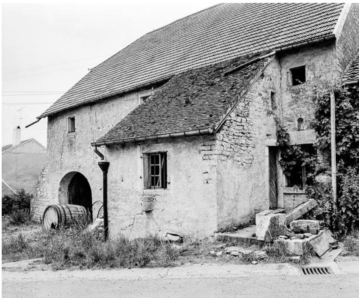
Détail : entrée d'habitation.
