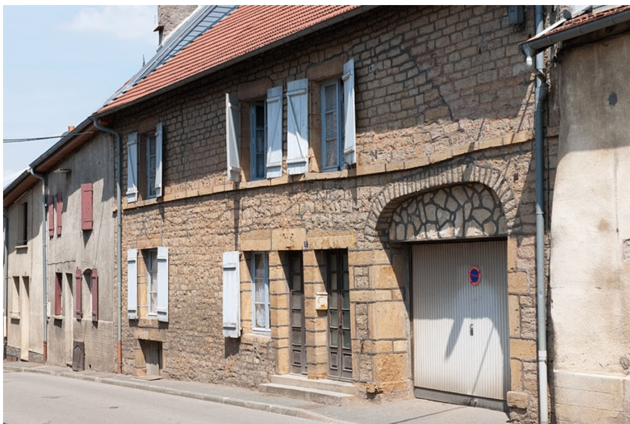
Façade antérieure, vue de trois quart droit.
