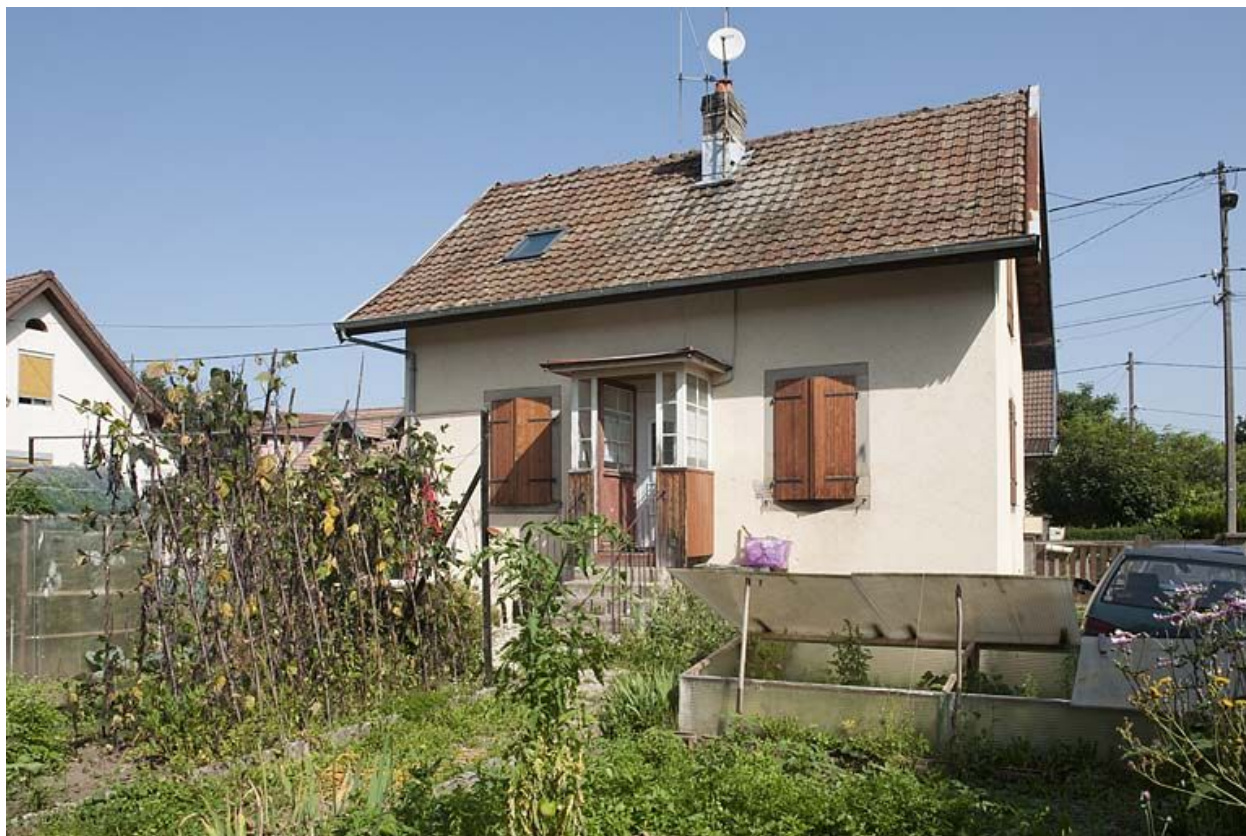
Maison individuelle rue des Lesses. Façade postérieure.
