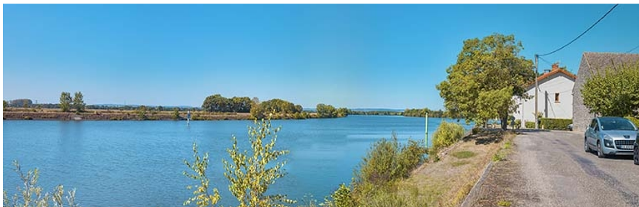
Rampe amont du port d'Ouroux.
