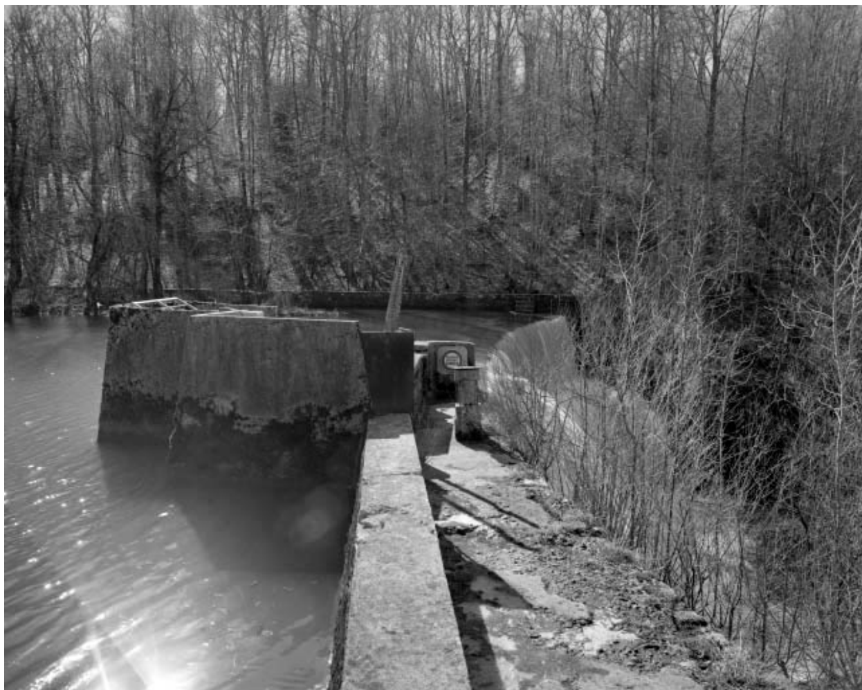
Tour de prise d'eau et barrage.
