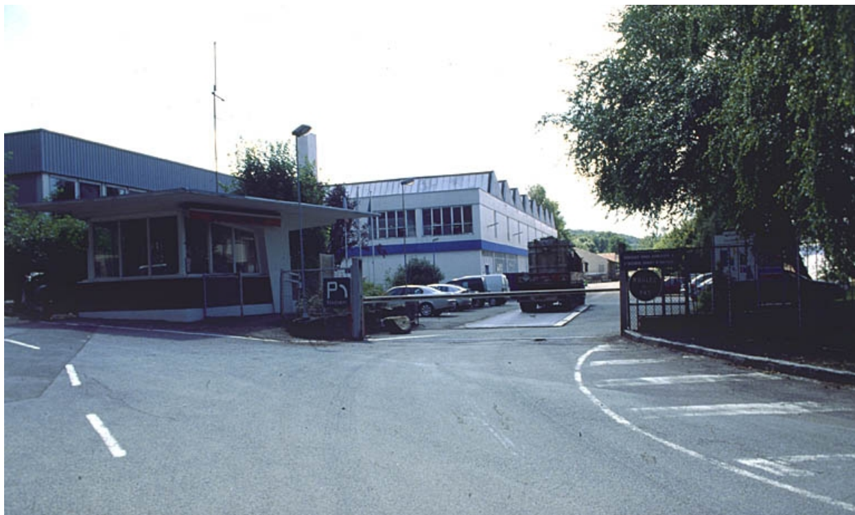
Entrée de l'usine.
