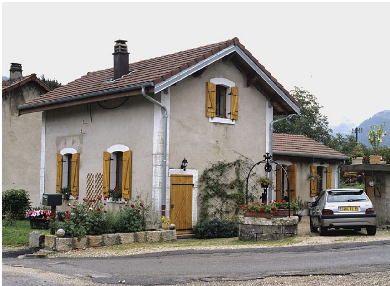
Façades nord et ouest.
