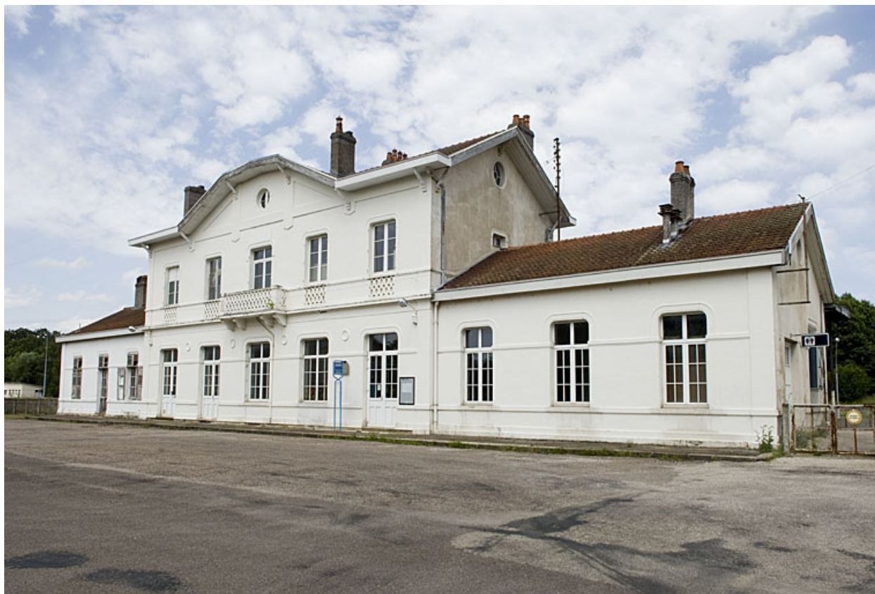
Bâtiment des voyageurs : vue générale depuis l'esplanade.
