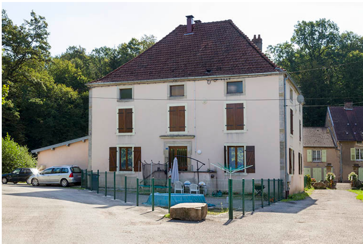
Maison, rue du Moulin.
