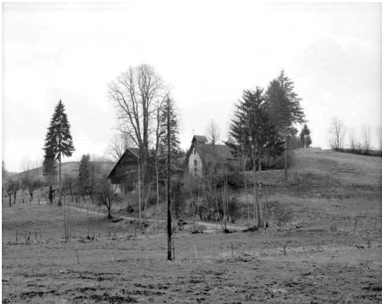
Façades antérieure et latérale.
