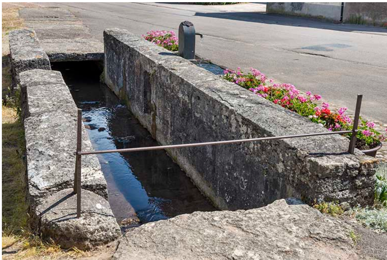
Le ruisseau canalisé alimentant les bornes fontaines.
