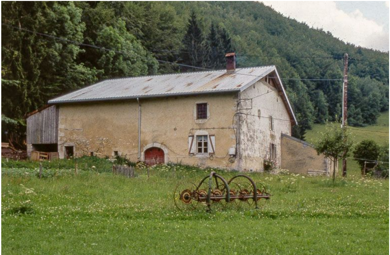
Vue éloignée de la façade postérieure.
