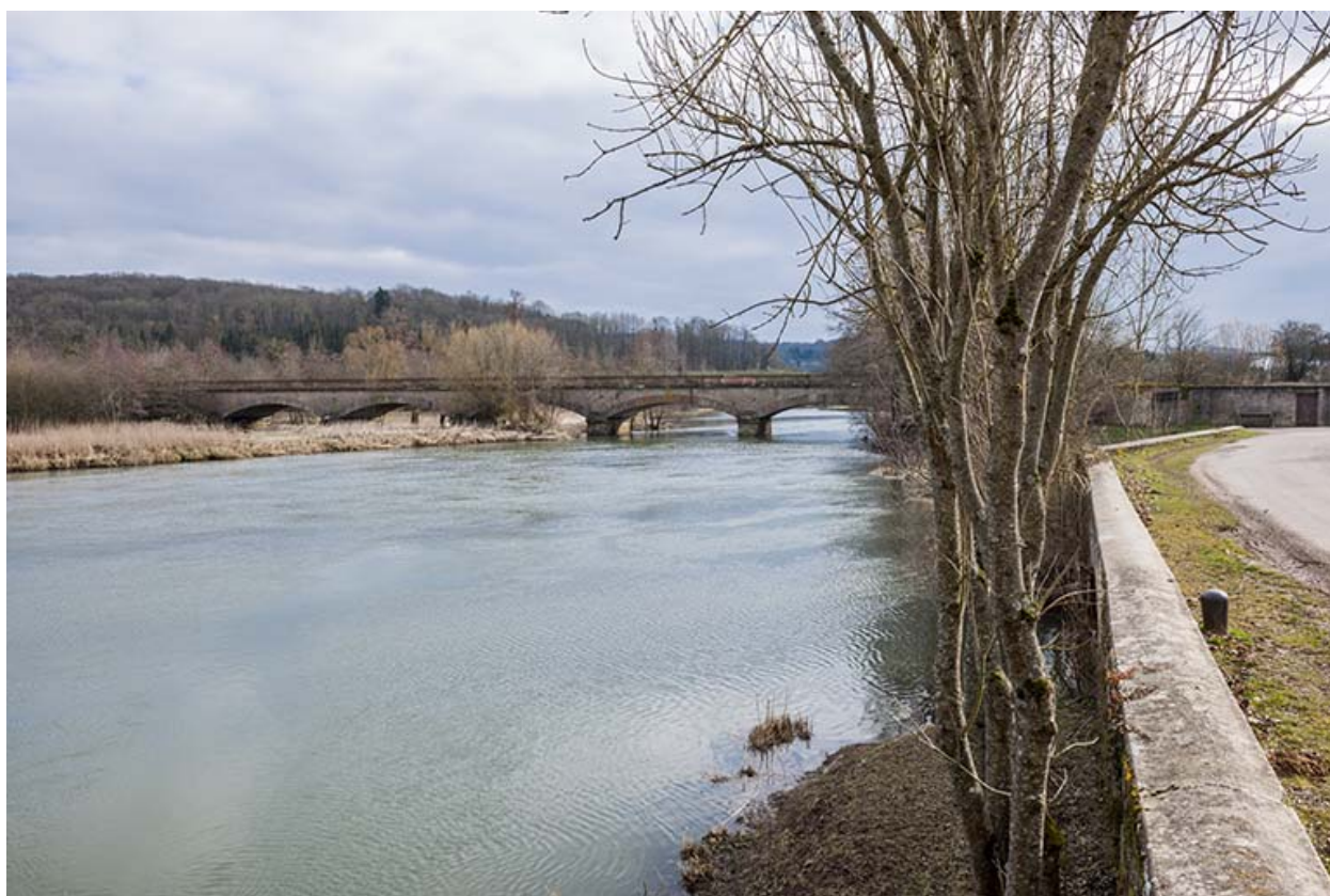
Pont ferroviaire sur la Lanterne (ligne Nancy-Gray).
