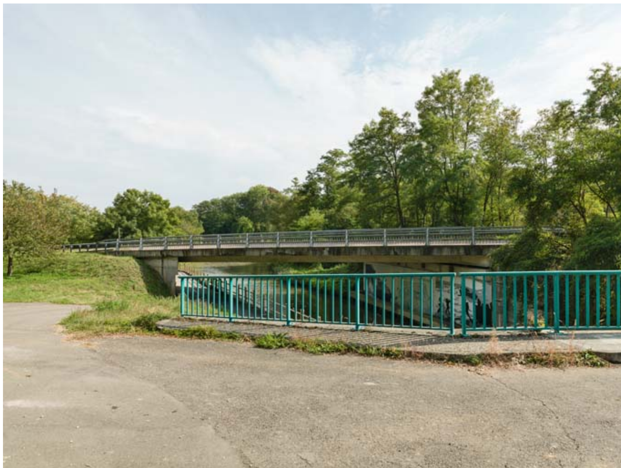
Vue d'ensemble du pont.
