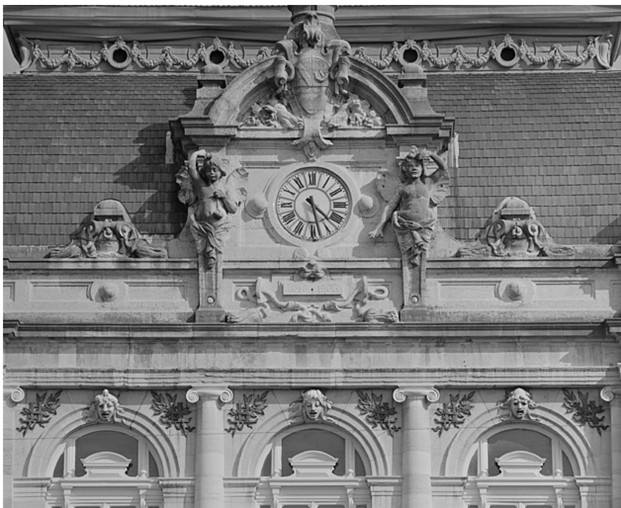
Façade antérieure, le couronnement.
