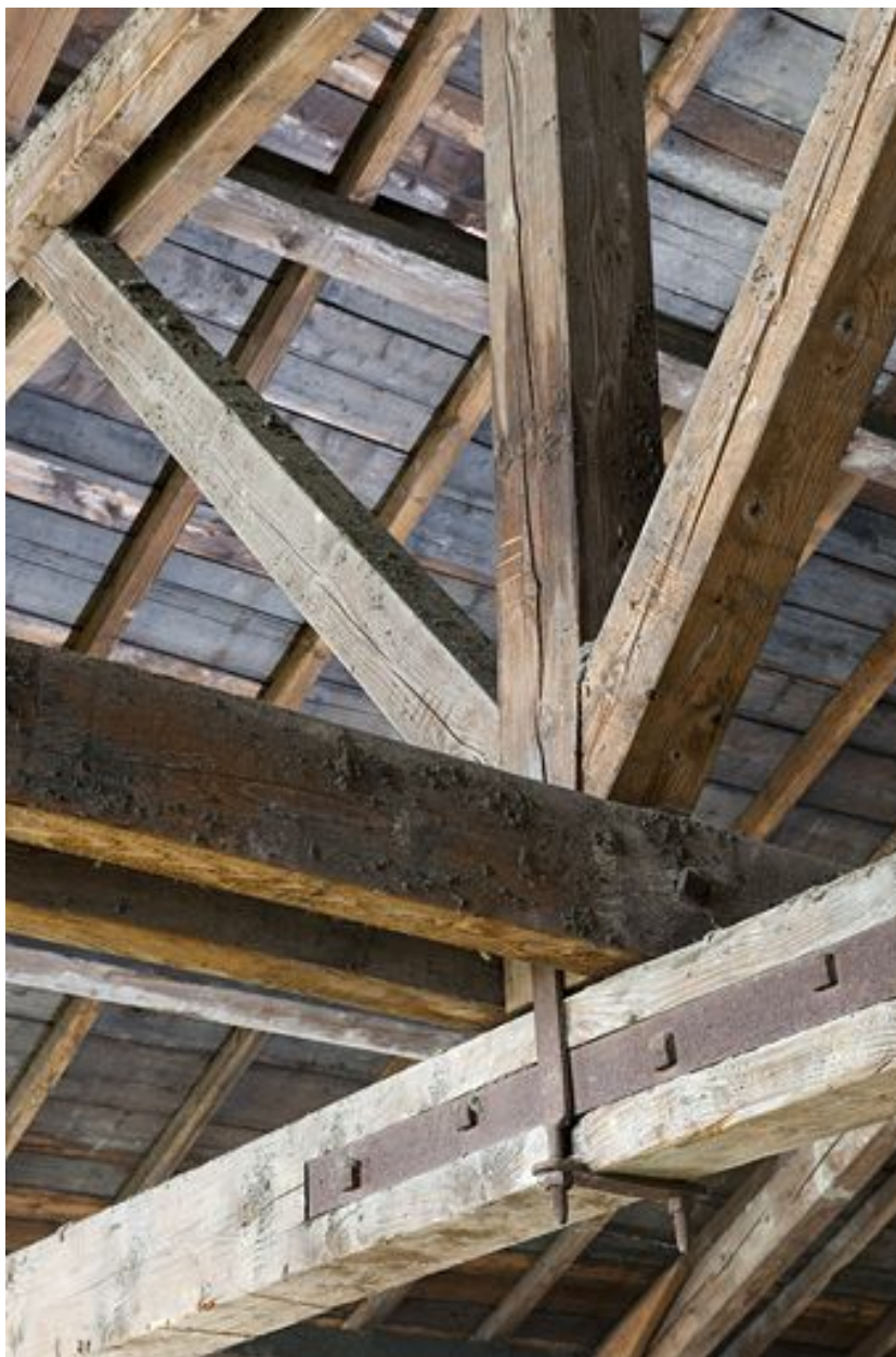
Entrepôt industriel. Charpente : jonction poinçon-entrait.
