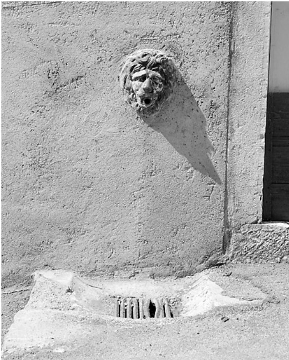
Bâtiment 3 rue Etienne Dolet : point d'eau.
