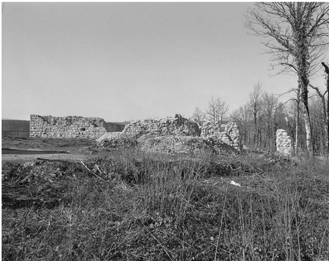
Vue générale du mur d'enceinte depuis l'est.
