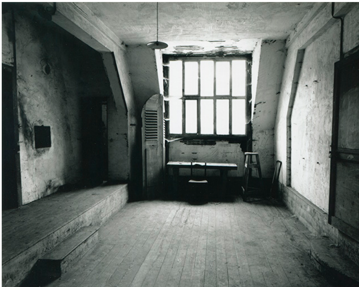
Etage de comble du bâtiment conventuel. Atelier, 1997.
