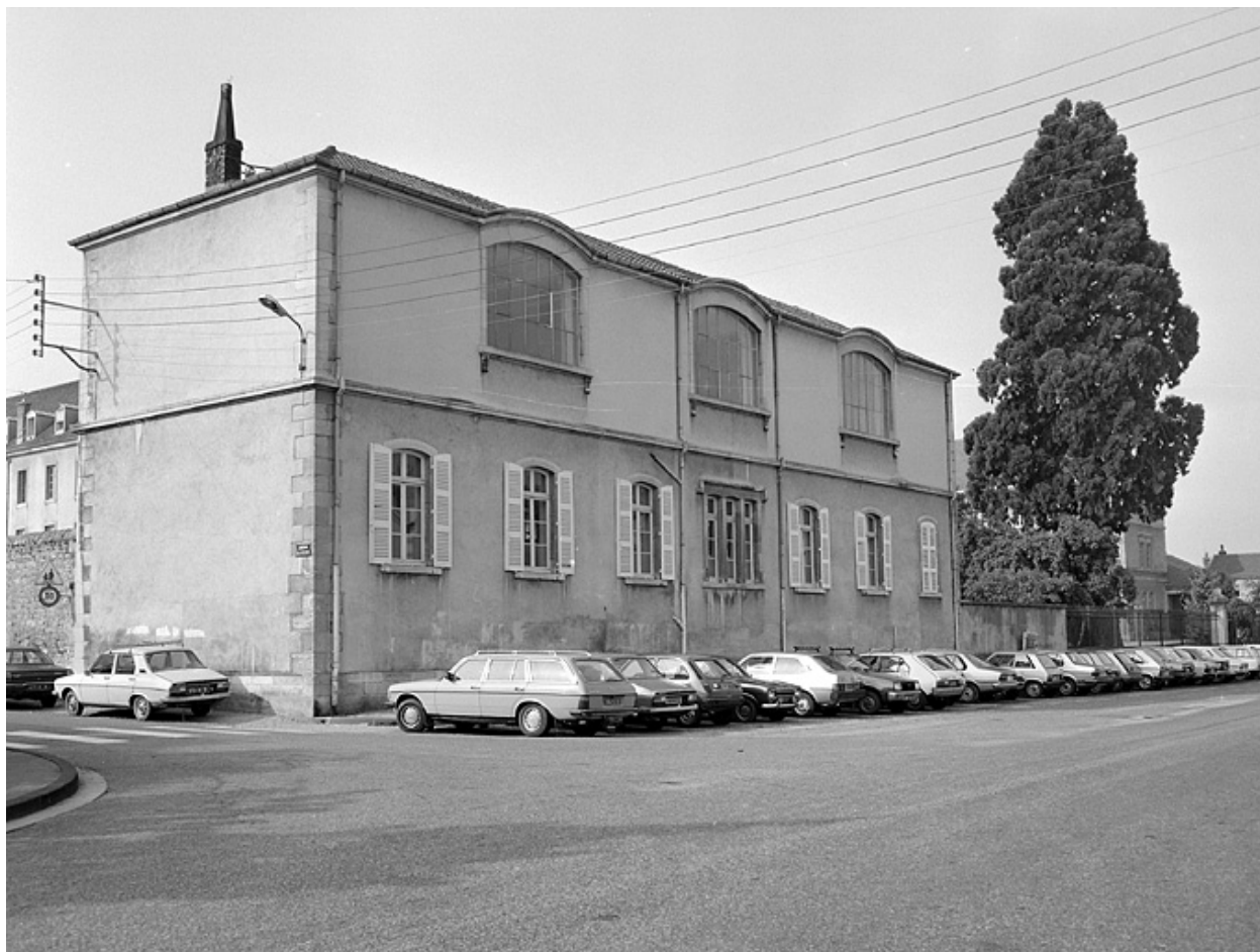
Bâtiment renfermant les salles de dessin.
