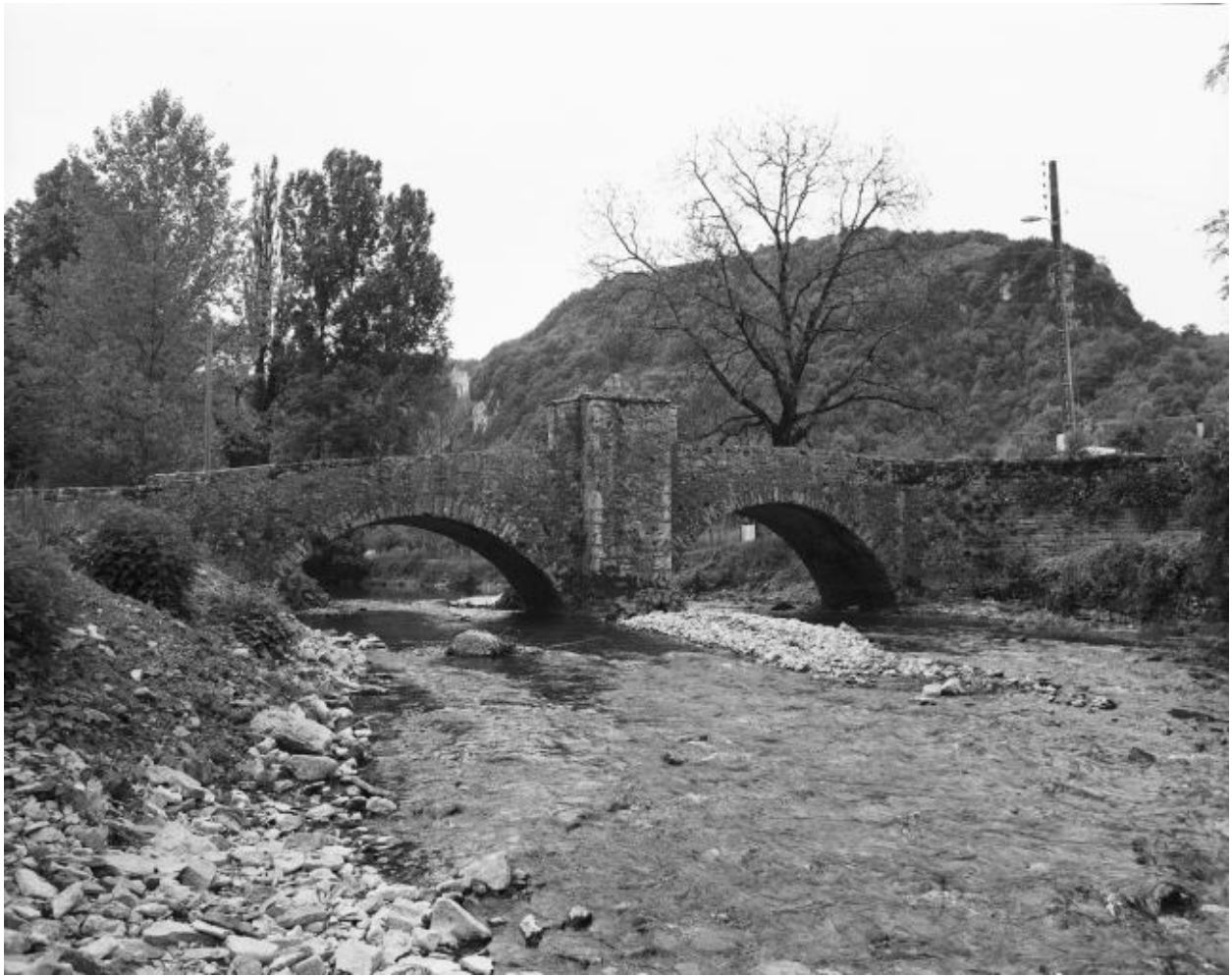
Face aval vue de trois quarts.
