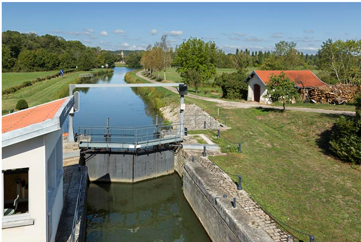
Vue de l'écluse depuis la passerelle métallique.
