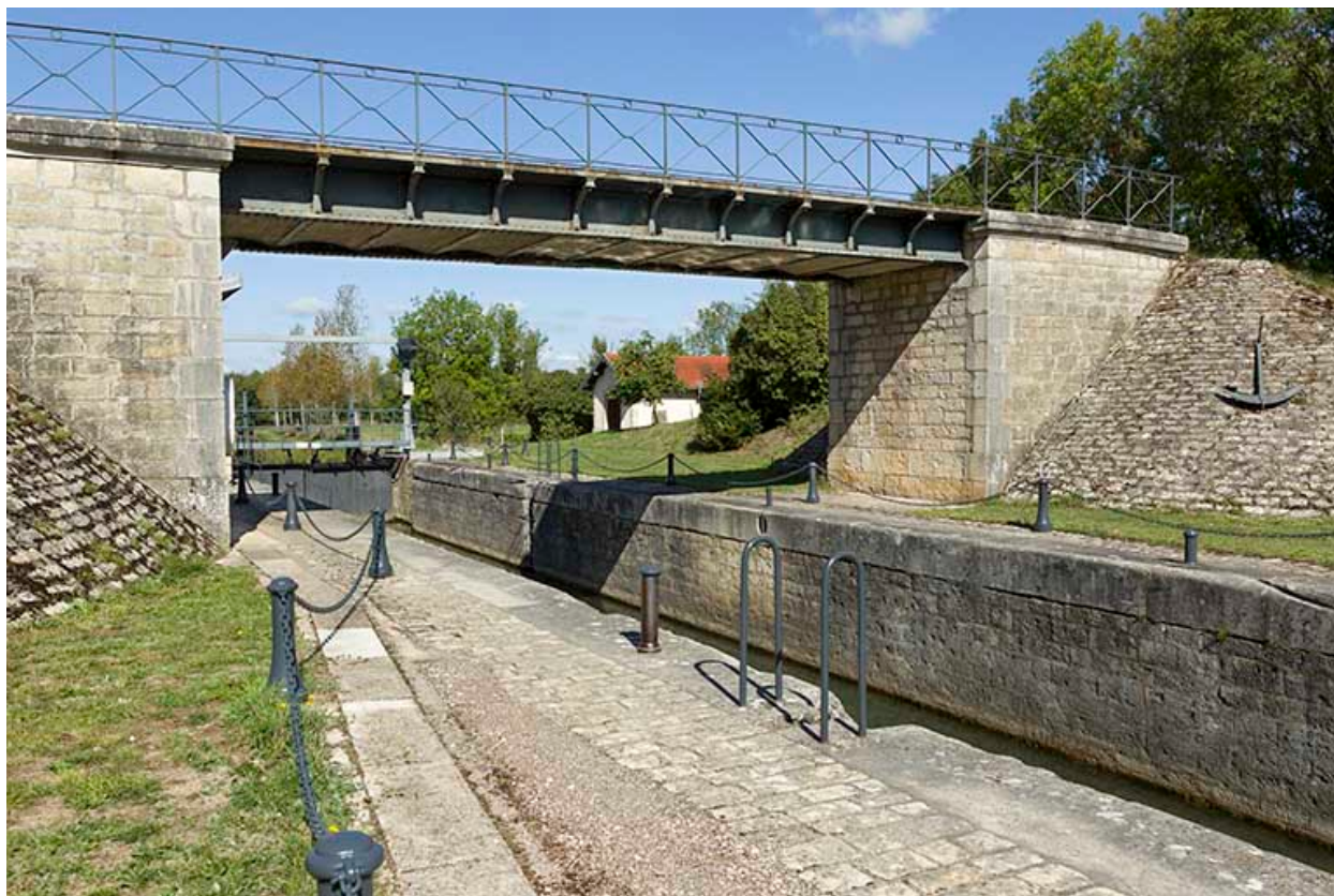
Le pont métallique au dessus de l'écluse.
