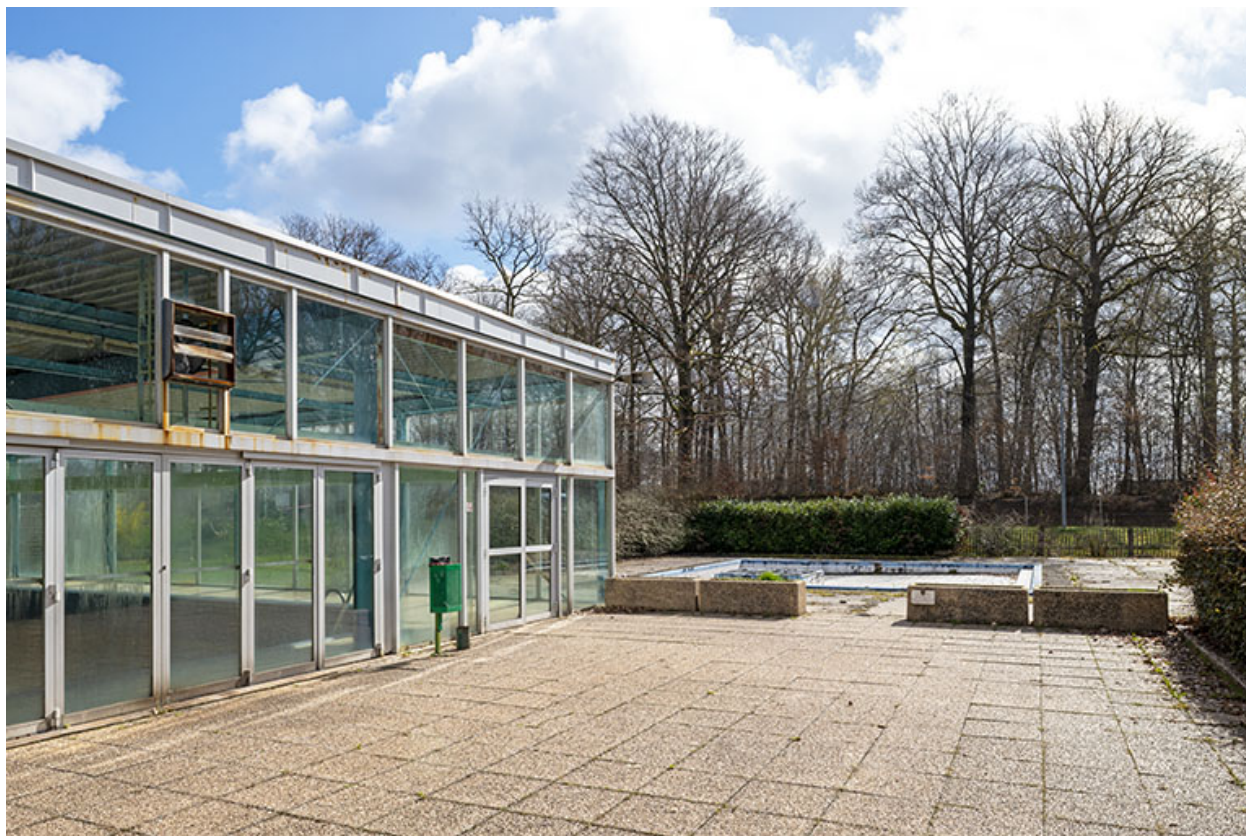
La façade sud-ouest de la piscine et la pataugeoire.
