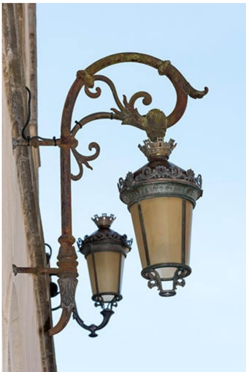
Façade antérieure : lanternes.
