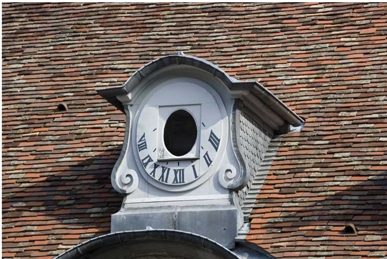
Détail d'une lucarne.
