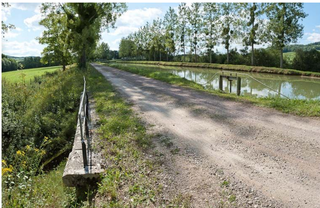
Vue du déversoir.
