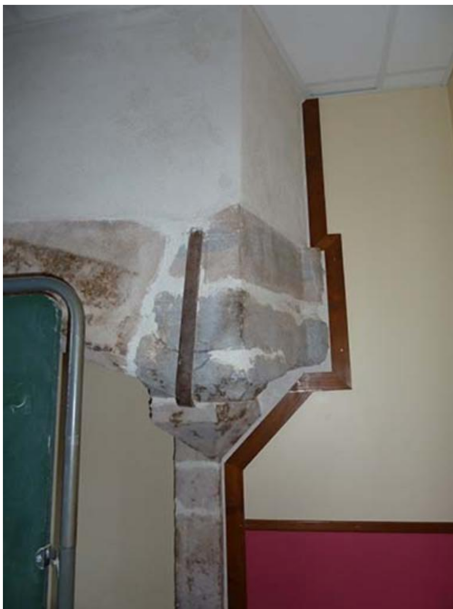
Détail du corbeau
