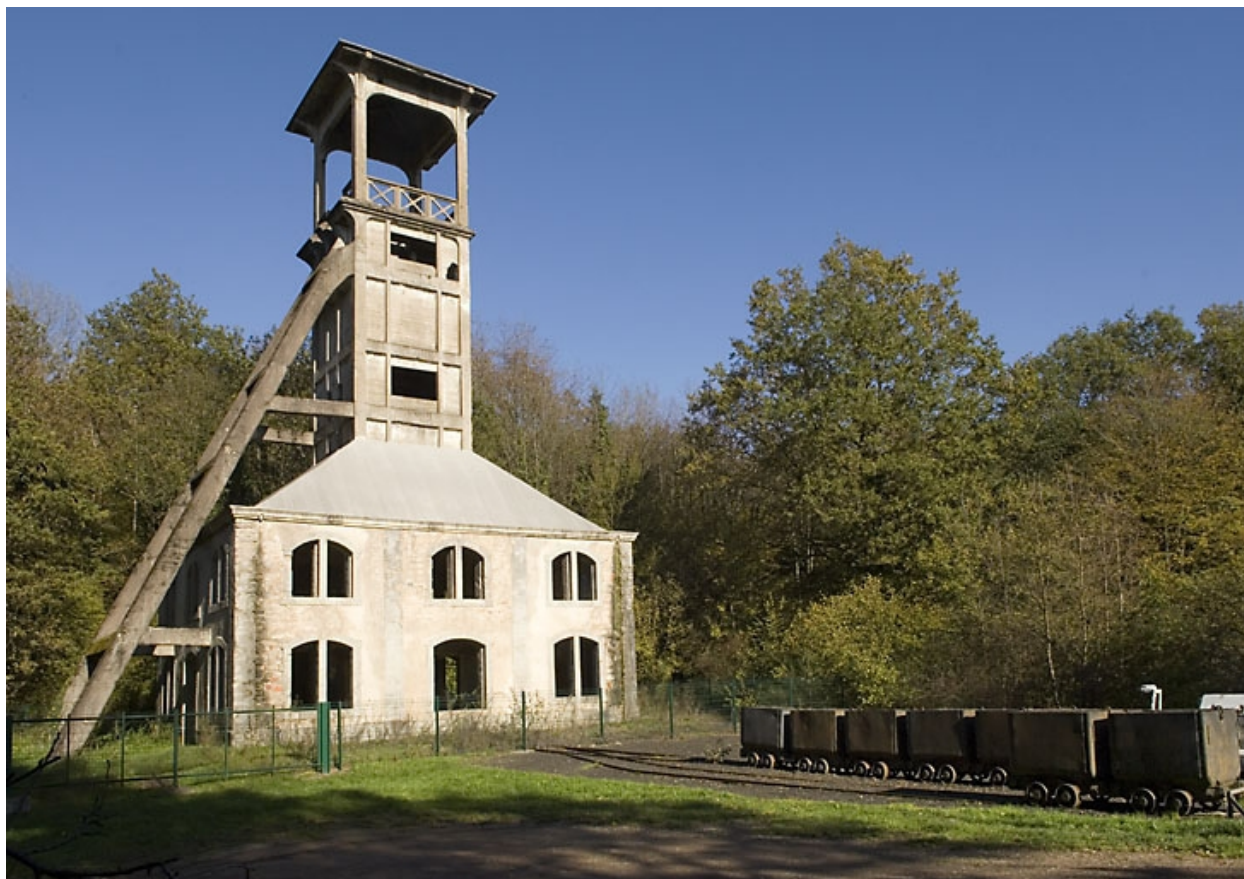
Mine de houille du puits Sainte-Marie, Ronchamp : le chvalement.
