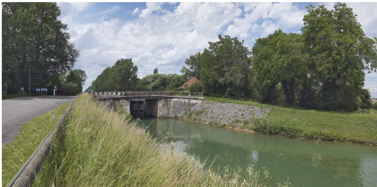
Pont vu d'aval.
