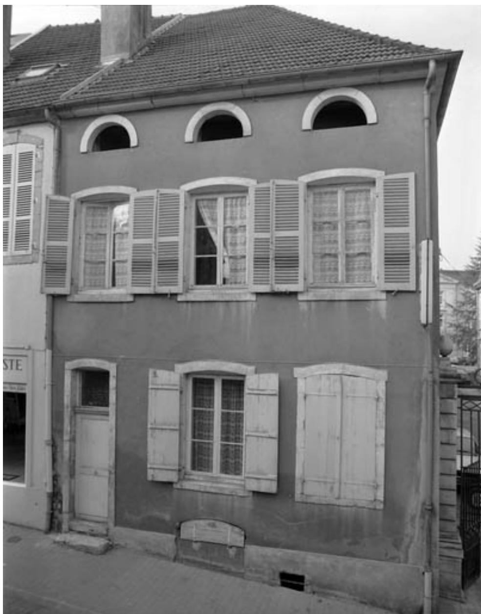
Logement de l'aumonier : façade antérieure de face.
