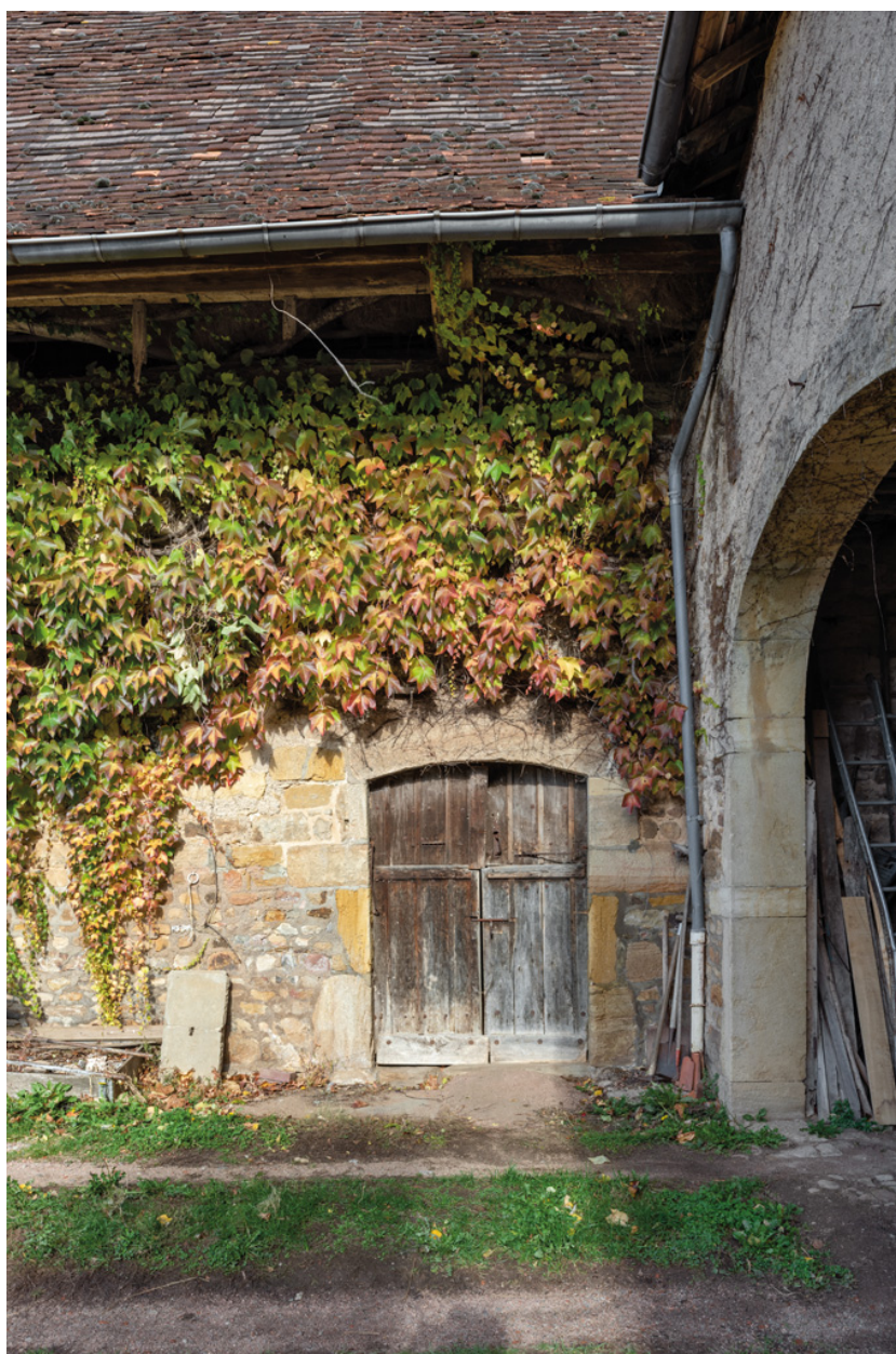
Porte d'étable du bâtiment nord.
