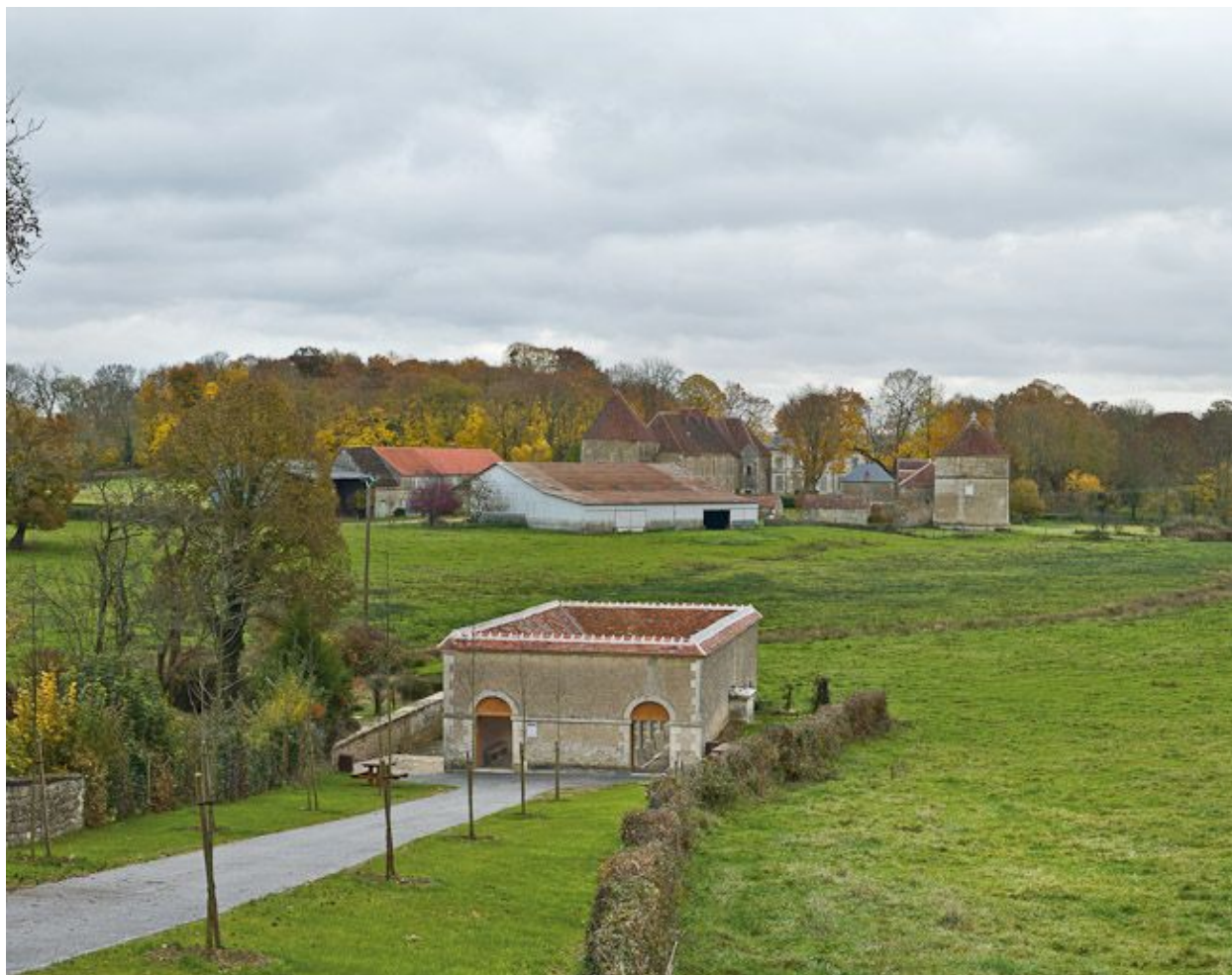
Vue d'ensemble du lavoir.
