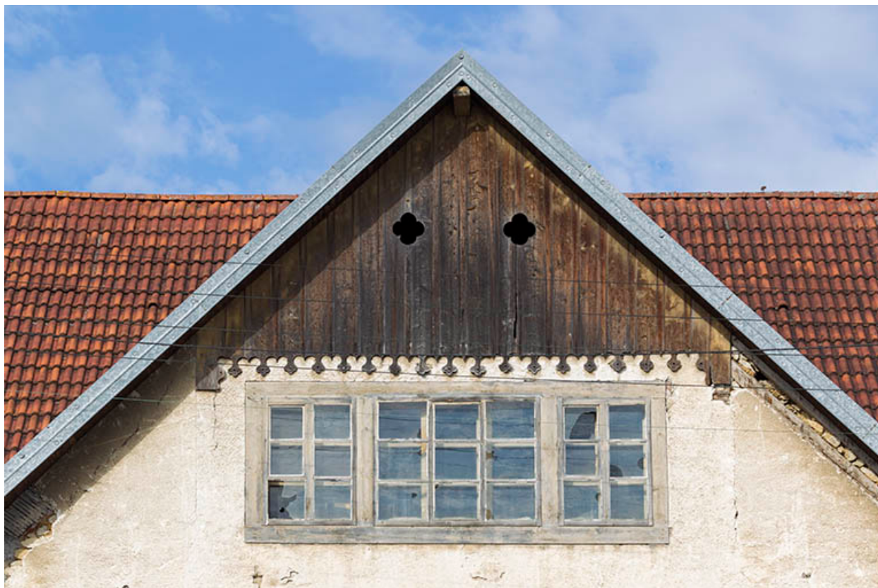
Façade antérieure : pignon.
