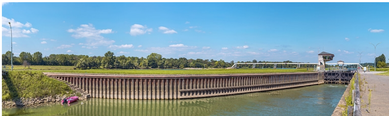
Murs-guides à l'aval du site d'écluse.
