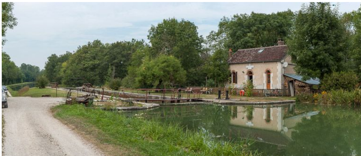
Vue d'ensemble du site d'écluse.
