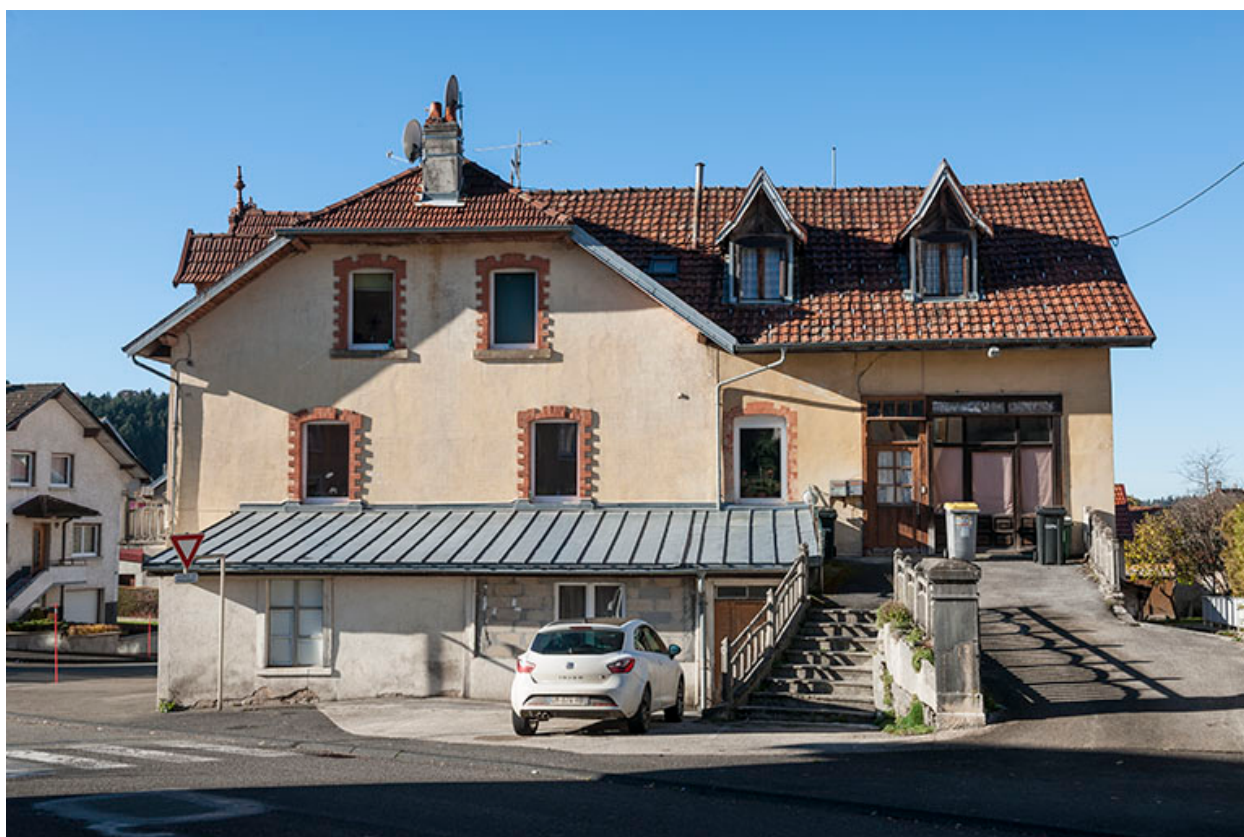
Façade latérale droite.
