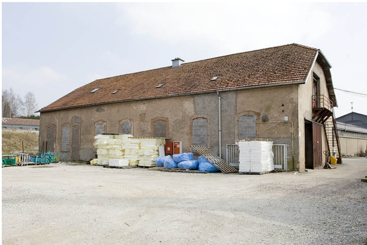
Moulin d'aval. Vue de trois quarts arrière.
