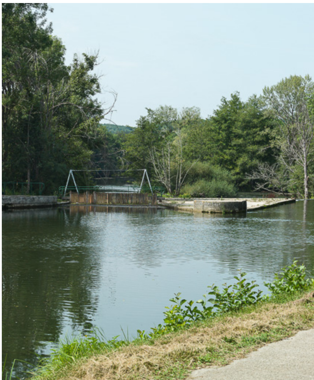
Vue du barrage.
