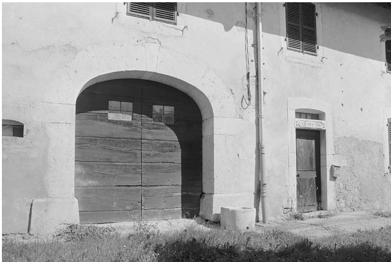
Porte de grange et accès au logis.
