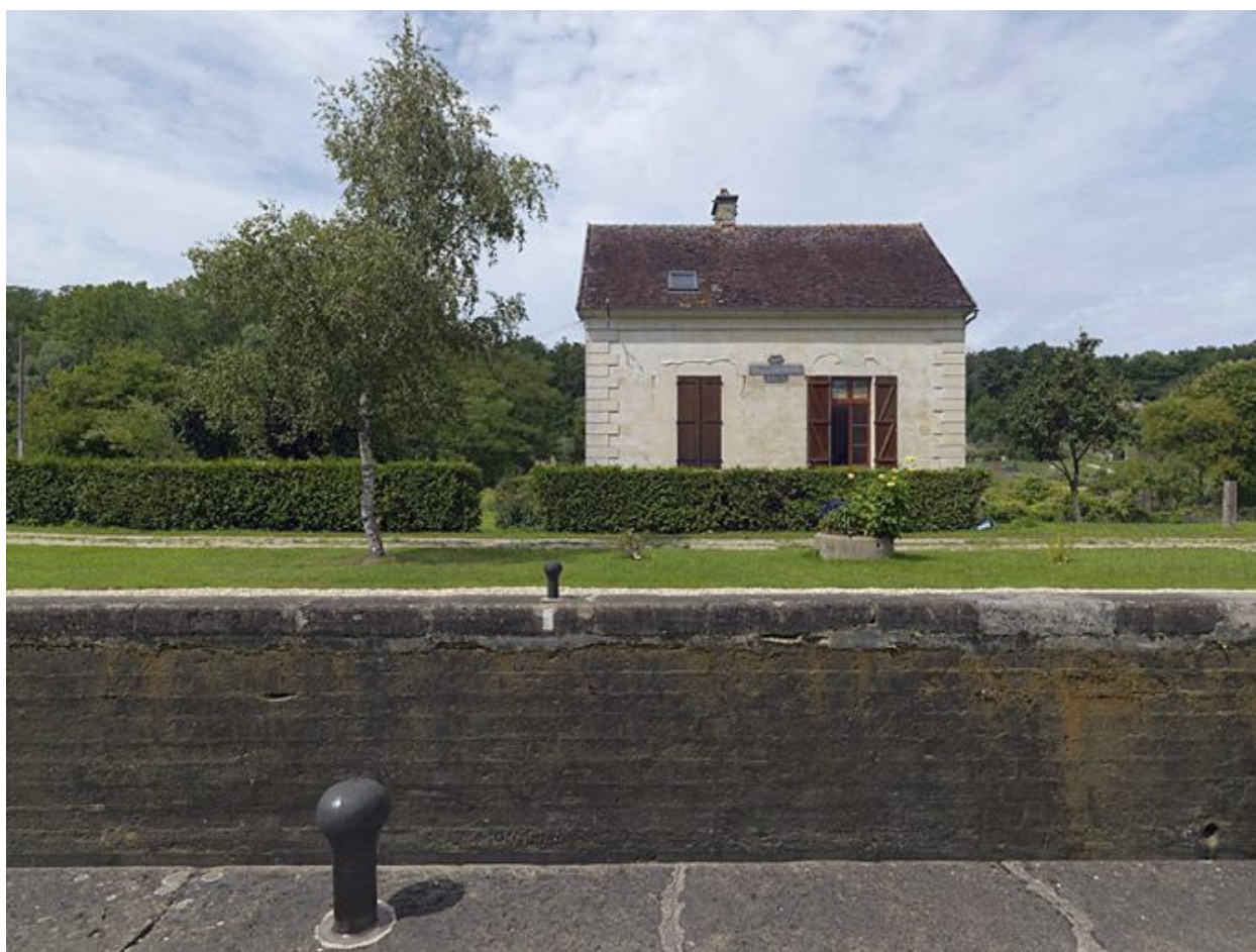
Maison éclusière : mur gouttereau sur canal.
